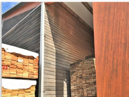
Voorbeeld van een ongelijk vergrijsde gevel.
